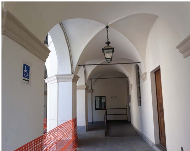
Le volte a crociera della porzione ad est
